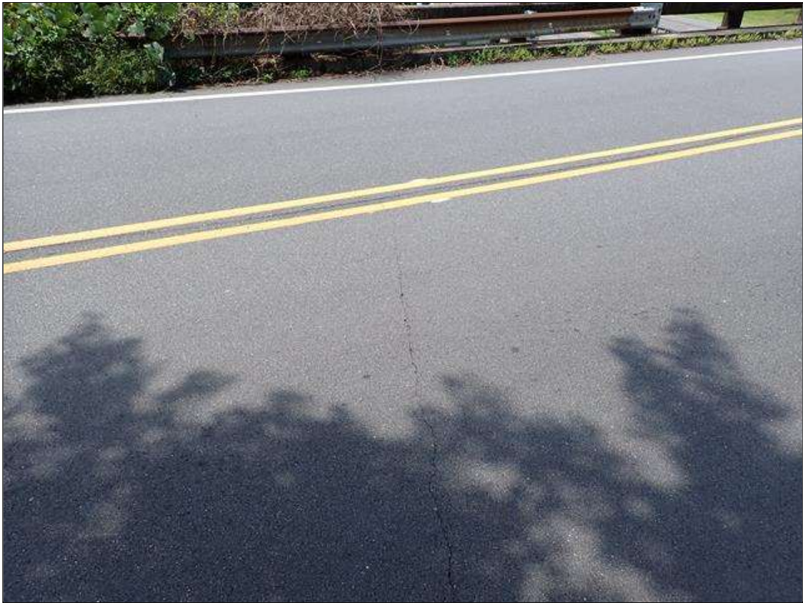
end bent 1 asphalt
