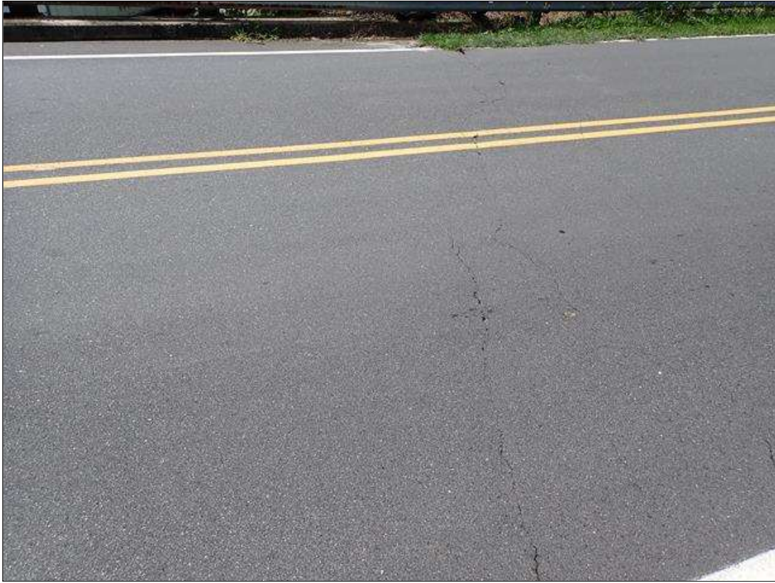
end bent 2 asphalt
